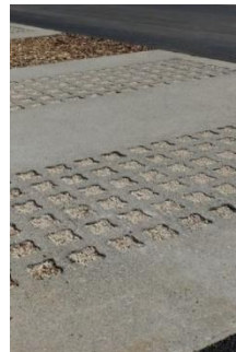
Béton alvéolaire avec un remplissage gravillonné
