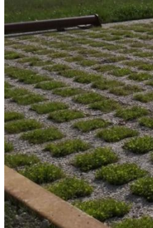
Béton alvéolaire avec un remplissage végétalisé
