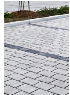
Les pavés drainants
