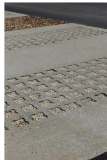
Béton alvéolaire avec un remplissage gravillonné
