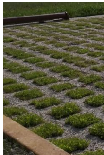
Béton alvéolaire avec un remplissage végétalisé
