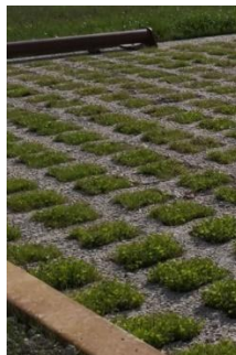
Béton alvéolaire avec un remplissage végétalisé
