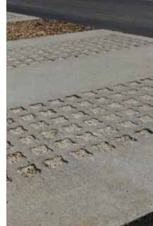
Béton alvéolaire avec un remplissage gravillonné
