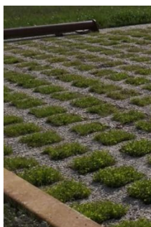
Béton alvéolaire avec un remplissage végétalisé
