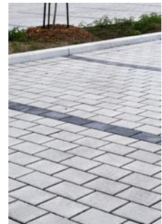
Les pavés drainants
