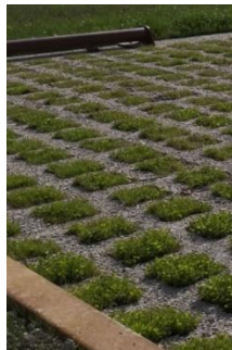
Béton alvéolaire avec un remplissage végétalisé
