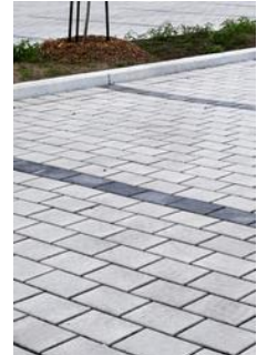
Les pavés drainants
