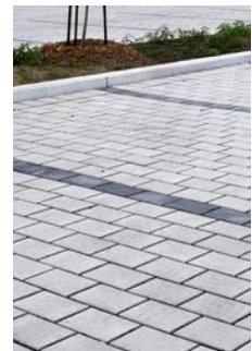
Les pavés drainants
