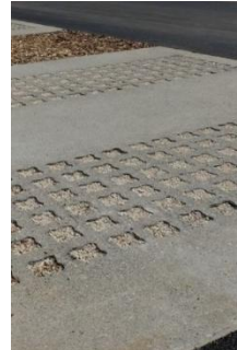
Béton alvéolaire avec un remplissage gravillonné
