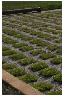
Béton alvéolaire avec un remplissage végétalisé
