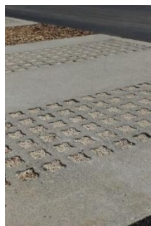
Béton alvéolaire avec un remplissage gravillonné
