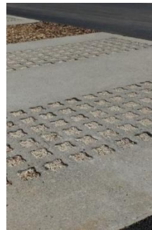
Béton alvéolaire avec un remplissage gravillonné
