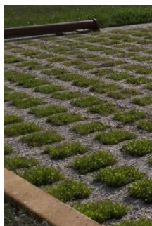
Béton alvéolaire avec un remplissage végétalisé
