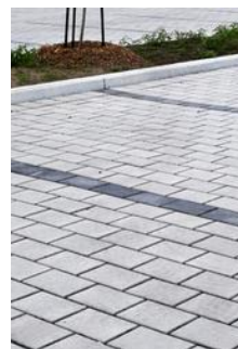
Les pavés drainants
