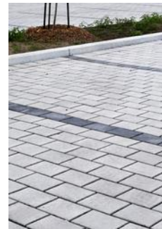
Les pavés drainants
