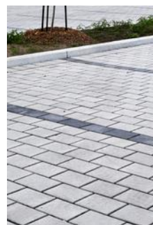
Les pavés drainants
