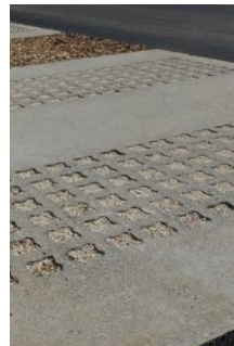
Béton alvéolaire avec un remplissage gravillonné
