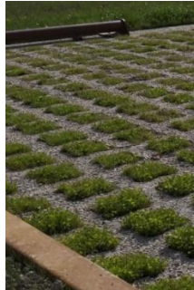
Béton alvéolaire avec un remplissage végétalisé
