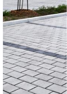
Les pavés drainants
