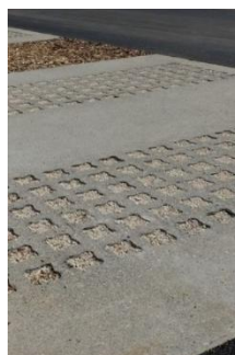
Béton alvéolaire avec un remplissage gravillonné
